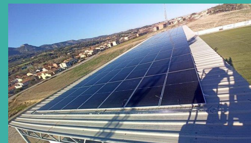
53 kWp - Balenyà Sostenible
